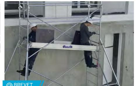
Plancher aluminium/bois ALTO à double trappe : risque de chute maîtrisé.
