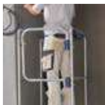
Garde-corps avec portillon sécurisé.
